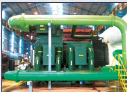
Каждая холодильная машина Thermax проходит двухступенчатое тестирование в гелиевой камере. Это позволяет гарантированно выявить любые нарушения целостности корпуса и утечки в установке.
