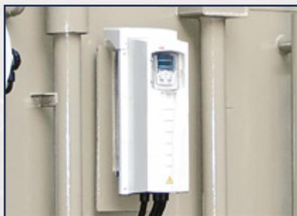
При постоянной температуре охлаждающей жидкости АБХМ Thermax может работать в диапазоне 10-100% расчетной мощности с плавным регулированием. Это избавляет от необходимости установки объемной буферной емкости. Это обеспечивается, в том числе, за счет использования частотных приводов насосов. Плавная регулировка частоты насосов АБХМ Thermax применяется для повышения надежности функционирования чиллера и экономии электроэнергии, особенно при работе на частичной нагрузке.
