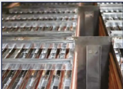
Подача хладагента и абсорбента самотёком решает проблемы износа, повреждения и закупорки распределительных форсунок в системах, которые используют конкуренты, применяющие систему подачи «распыление под давлением». Применение самотечной подачи исключает возможность кристаллизации раствора LiBr в системе при внезапном отключении электроэнергии.
