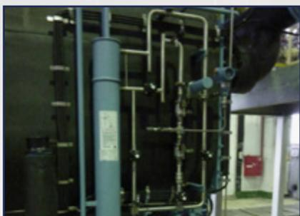
Заводская система продувки в режиме реального времени поддерживает низкий вакуум в корпусе и обеспечивает устойчивую выработку холода. Она состоит из вакуумного насоса, бака-накопителя, труб и клапанов. Неконденсируемые газы, образующиеся в процессе работы АБХМ, поступают в бак для продувки и автоматически удаляются оттуда вакуумным насосом.
